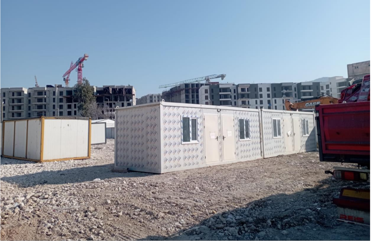
Fotoğraf: Hatay Armutlu TOKİ inşaat alanı (Ocak 2025)
